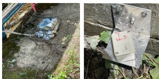
(a) 擁壁上部設置 (b) 擁壁下部設置
