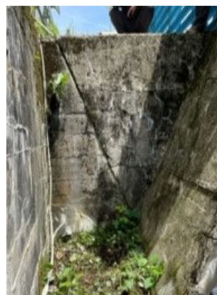
写真 1 観測対象の擁壁
