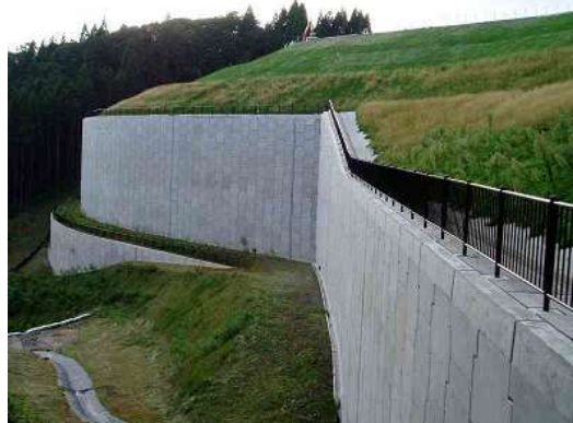
図-1 テールアルメ壁の外観
