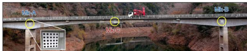
図-2 ドローン空撮によるドゥルックバンド橋のたわみ計測
