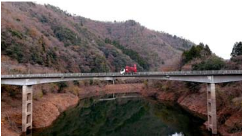
図-3 橋梁の外観
