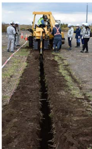
写真-2 トレンチャー掘削状況
