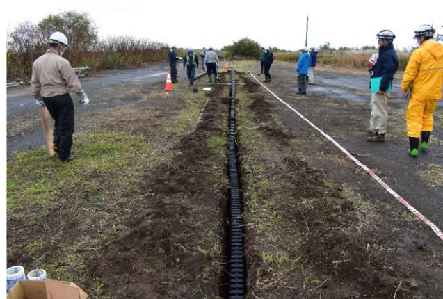
写真 3 管路材敷設状況
