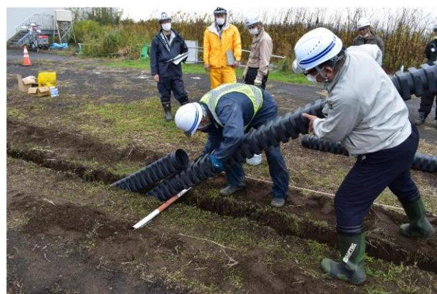
写真 4 管路材接続状況
