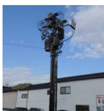
図2. 変圧器柱
