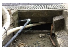
図3. 排水側溝貫通
