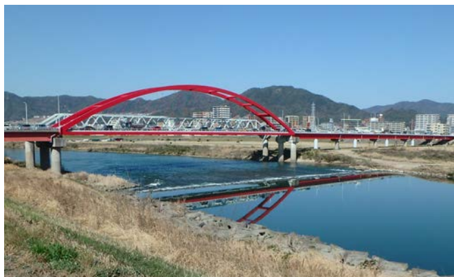
写真1. 安芸大橋（太田川上流より撮影；著者, 2023年）
