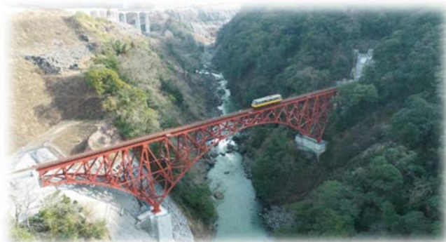
写真-3. 第一白川橋梁完成写真
