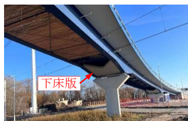
写真-1 二重合成I桁橋
