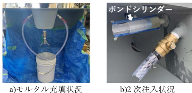
図 2 軽量樹脂モルタル施工状況
