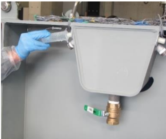
図 6 低圧注入器具による 2 次注入状況
