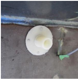
図 3 座金接着状況
