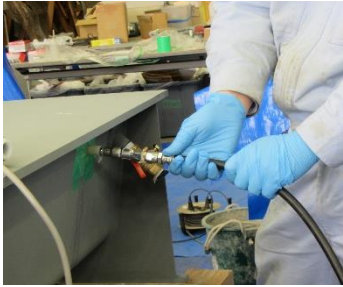
図 7 小型注入用ポンプによる 2 次注入状況
