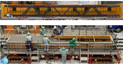
(c) 上段: コンクリート打込み前 下段: コンクリート打込み状況
