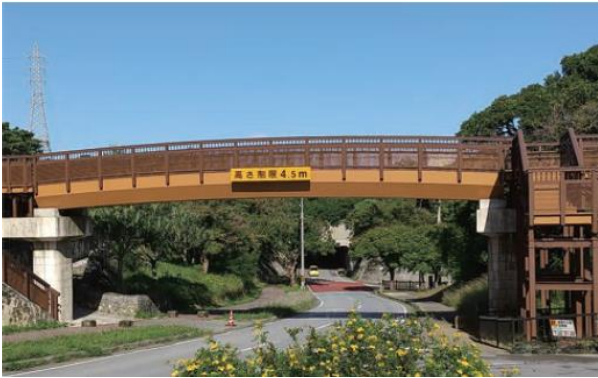
図-1 VI 成形法により製作された GFRP 歩道橋 1)
