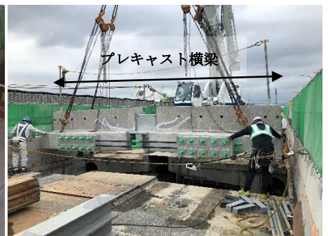
写真2 プレキャスト部材の据え付け
