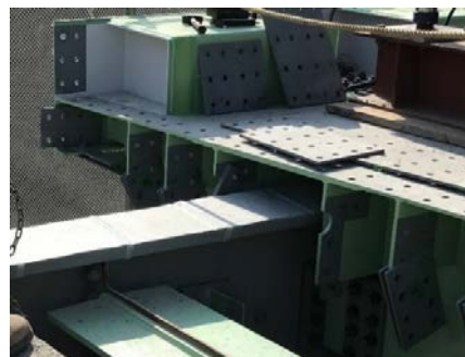
図-5 粘着系シートラッピング状況
