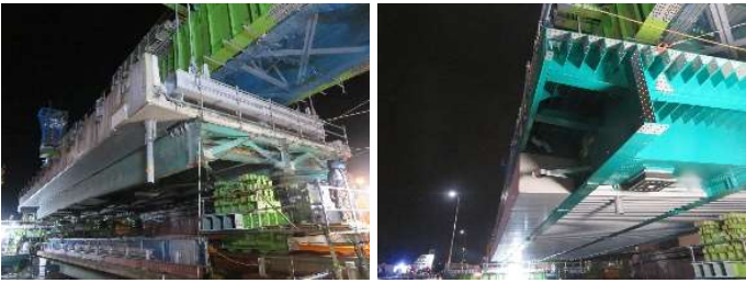
(a) 既設桁の撤去 (b) 新設桁の架設 図-5 既設桁の撤去、新設桁の架設
