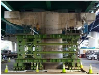
図-4 既設橋脚ベント補強
