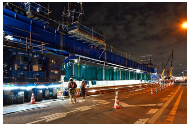
図-3 新設桁架設状況写真
