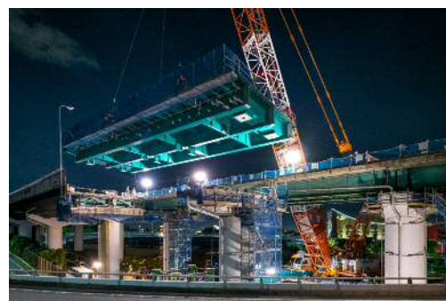
図-5 新設桁一括架設 状況写真
