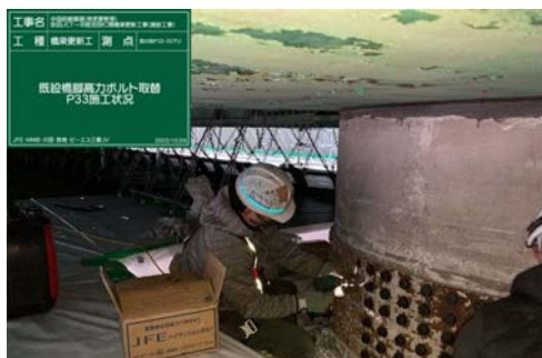
写真 1 高力ボルト入替
