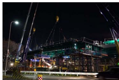
写真 3 主桁架設状況
