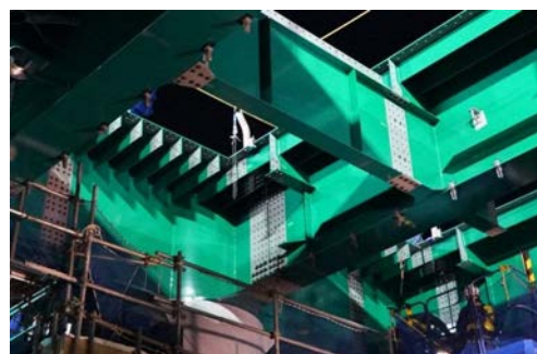
写真 4 暫定添接状況
