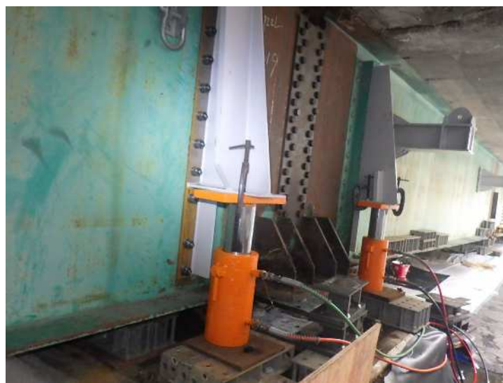
写真-1 中間支点ジャッキアップ
