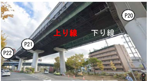
写真 - 1 桁下状況
