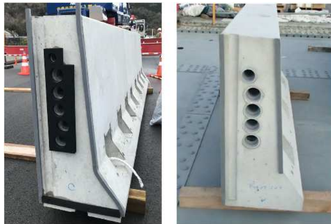
写真-3 通信管ジョイント部比較 (左図: 従来構造 右図: 新規採用構造)
