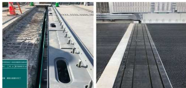
写真-4 暫定伸縮装置 設置状況 (左: 鋼製台座据付 右: 暫定伸縮装置設置完了)
