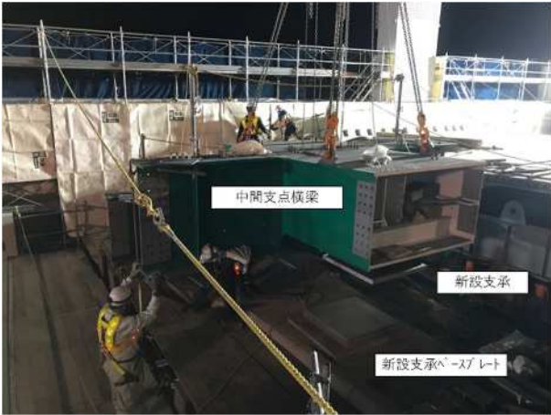
写真-2 中間支点横梁架設(終日通行止め期間中)
