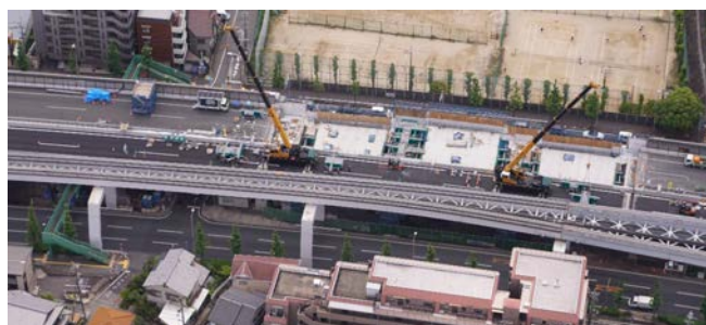
写真-1 豊中高架橋 現地状況
