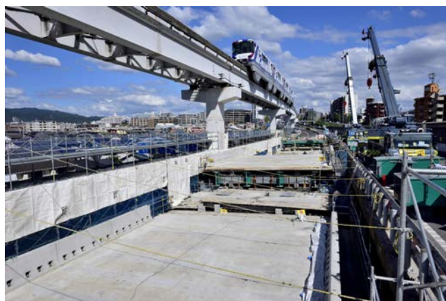
写真-2 ジャッキアップ架設工法施工状況
