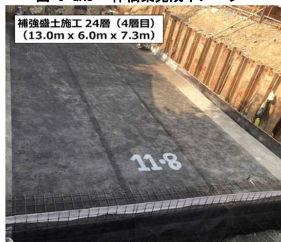
図-7 補強盛土施工状況
