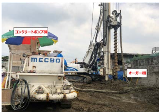
図-3 CFA 工法施工状況
