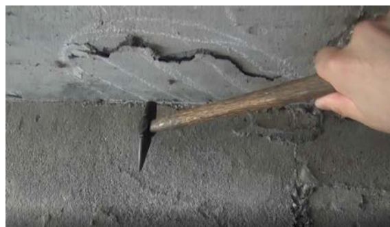
図5 打音検査の収録状況
