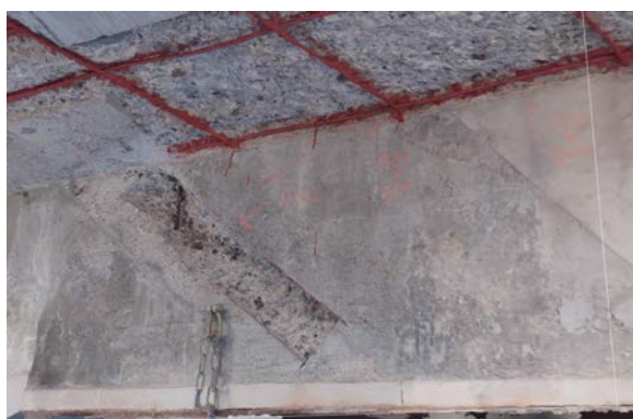
(b) コンクリートのはつり時
