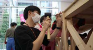
図-8 木橋の組み立て
