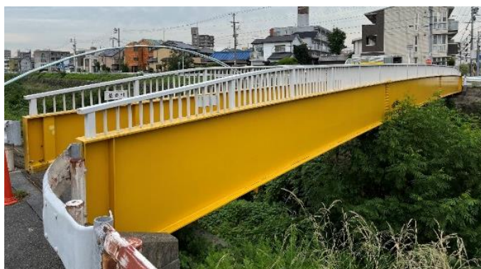
写真 - 1 測定対象橋梁
