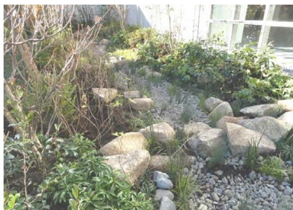
図-6 施工したDEWレインガーデン
