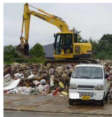
写真-1 仮置場での集積状況
