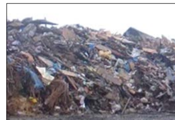
写真-1 仮置場の集積状況
