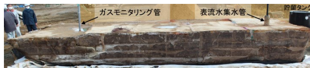
図3 解体時の固化埋立層の側面観察状況
