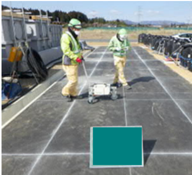
図-3 わだち掘れ量測定状況
