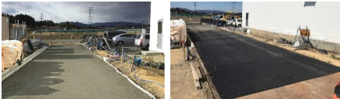
(路盤) (アスファルト舗装) 図-1 構築完了状況
