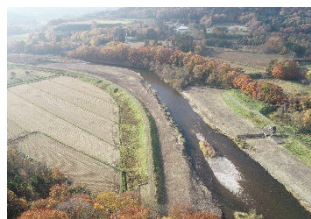
令和元年10月 伐採・除根後
