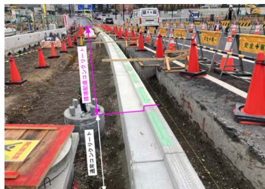
写真-2 道路排水側溝製品の現地設置状況
