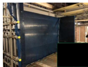
図 2 防音パネル現場設置状況
