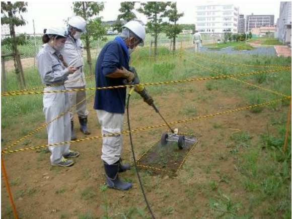
写真 1 熱水除草の施工状況
