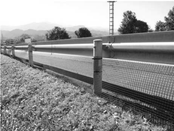
写真 1 侵入対策設置状況
