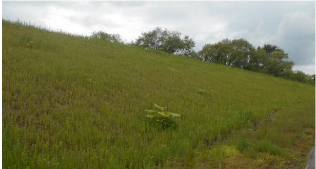
図1 在来種緑化法面（令和4年6月）
