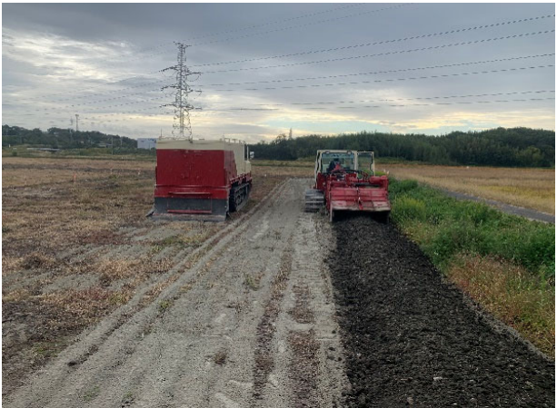
写真-2 施工状況
