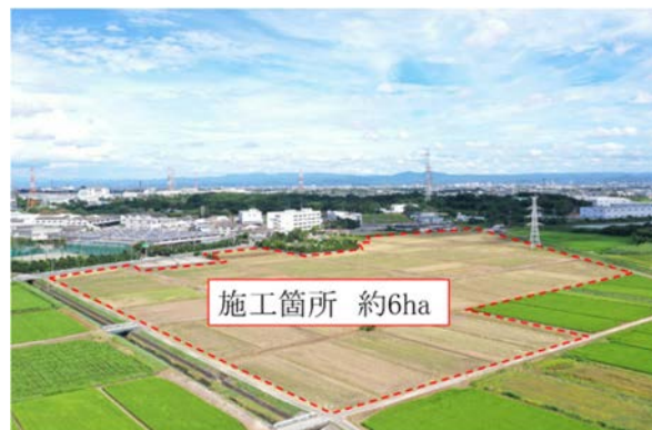
写真-1 現場写真
