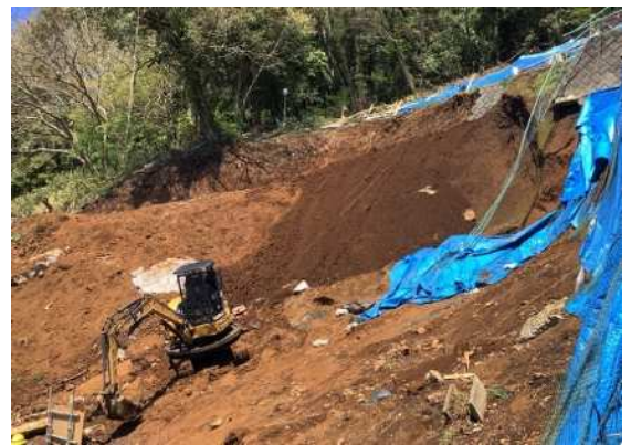
写真-4 セーフティクライマー工法状況
