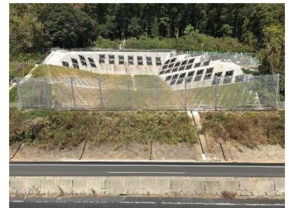
写真-6 本復旧の完了状況
