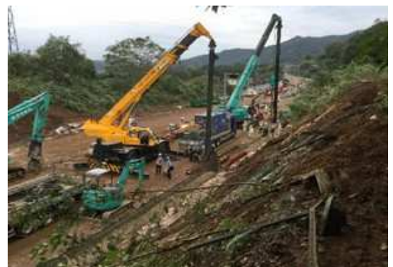
写真-2 親杭の打設状況
