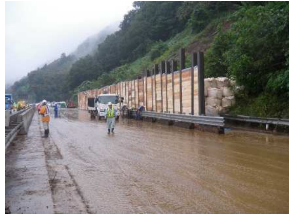
写真-3 本線応急復旧の完了状況
