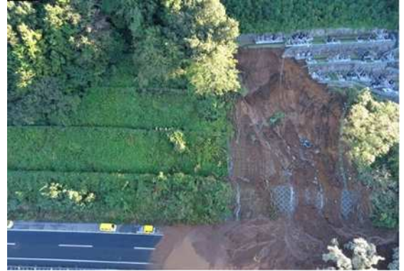
写真-1 被災状況
