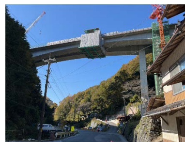
写真-2 中央閉合施工
