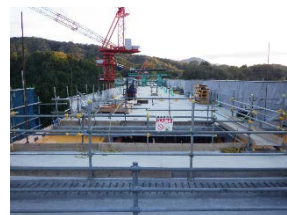
写真-1 分割施工写真
