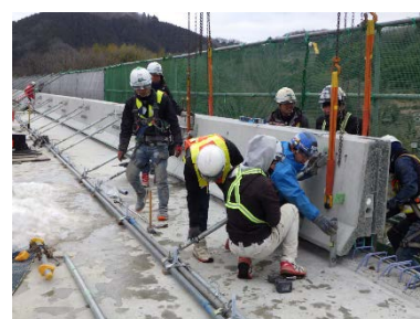
写真-3 プレキャスト施工状況
