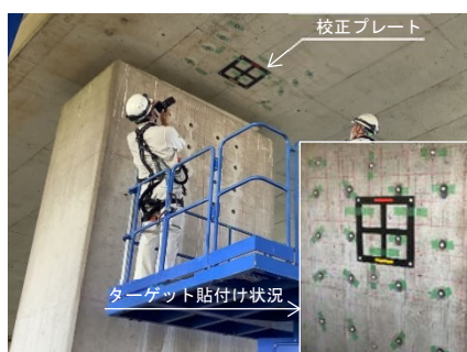
写真-1 カメラによる計測状況
