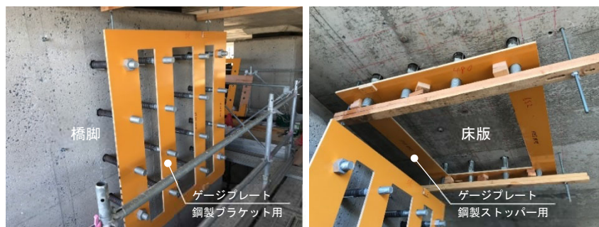
写真-2 ゲージプレートのセット状況
