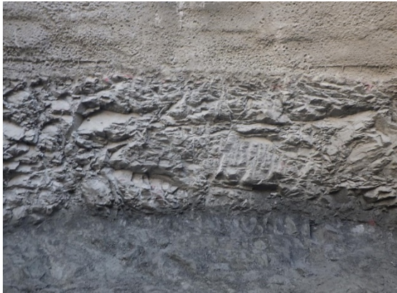
写真-2 深度 9m 付近の硬岩掘削面
