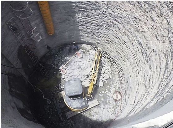
写真-1 Case B での施工状況
