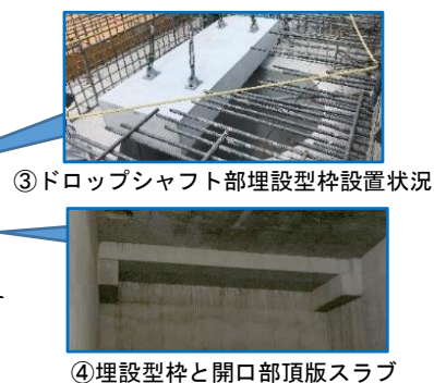
図-3 頂版スラブ施工フロー
