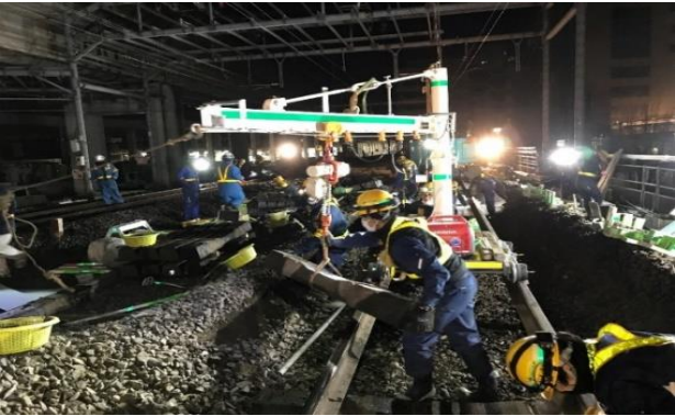
写真-3 簡易クレーンを使用した施工
