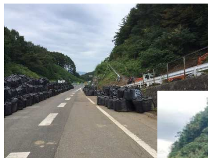
応急復旧工事前状況
