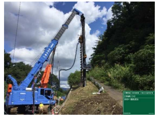
写真-1 C-Box42 杭打設状況
