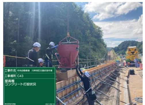
写真-3 C-Box43 壁高欄コンクリート打設状況
