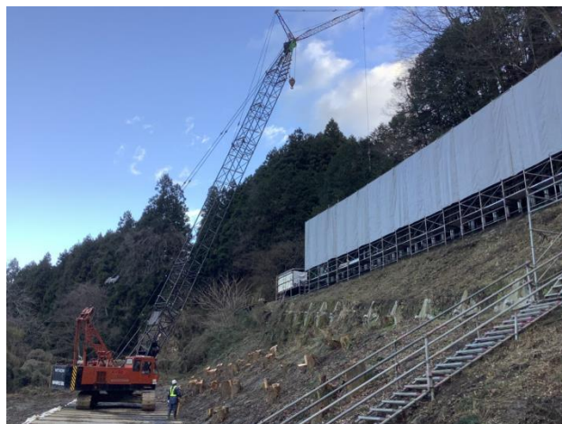
図-5 工事施工状況
