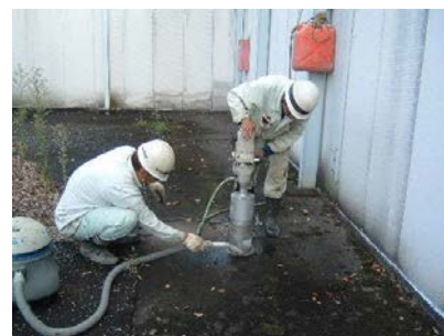
写真-1 土壌汚染調査の状況
