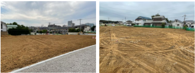
写真-1 試験現場写真(左:西エリア, 右:北エリア)
